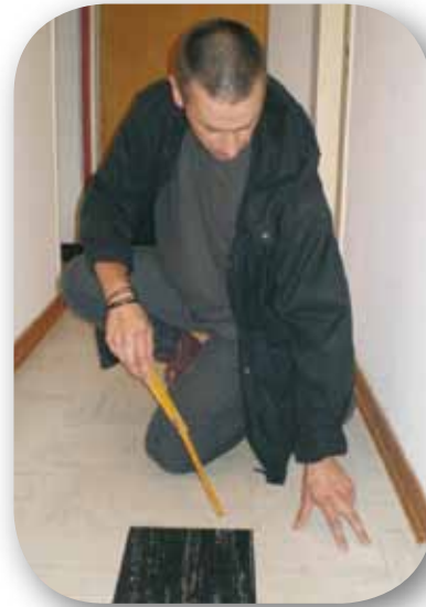
Asbestverdacht bei PVC-Bodenbelag
