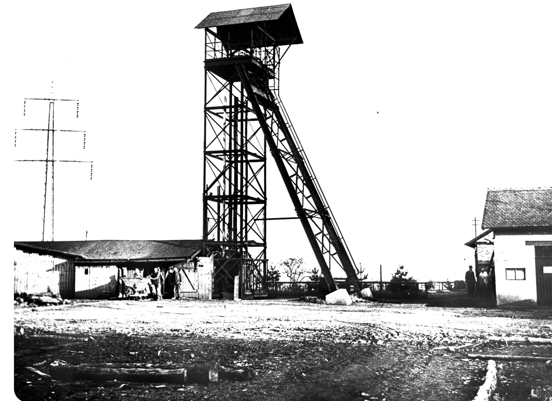
(2) Alfredschacht von Norden 1937. Das Betriebsgebäude links und der Förderturm stehen nicht mehr. Rechts, heute dicht an der Straße, das "Haspelhaus"**, in dem die Fördermaschine bedient wurde. Dahinter eine Ecke des Zechenhauses, heute (2011) leider stark verfallen.
